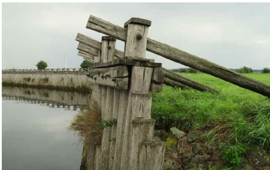
Fig. 7; Reconstructie van een palendijk nabij Spakenburg.
